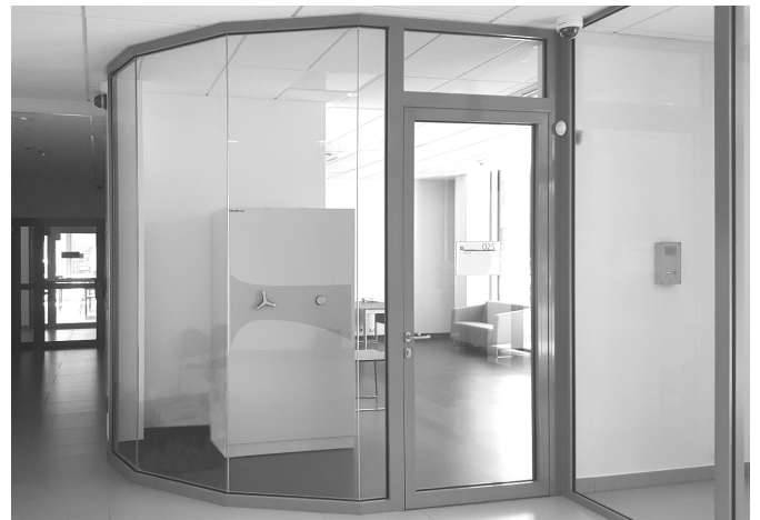
Zdj. 12. Przykład połączenia kąтового konstrukcji AVL - zdjęcie z realizacji zgodnie z powyższym przekrojem
