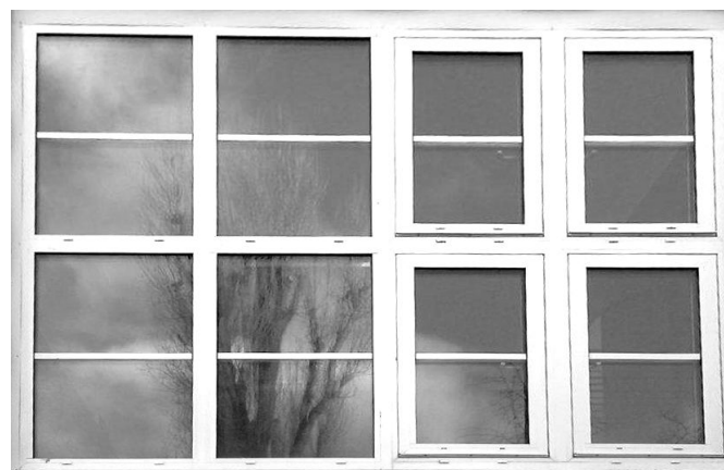
Zdj. 2. Przeciwpożarowe okno techniczne ALUFIRE ze ścianą stałą (szprosły międzyszybowe)
